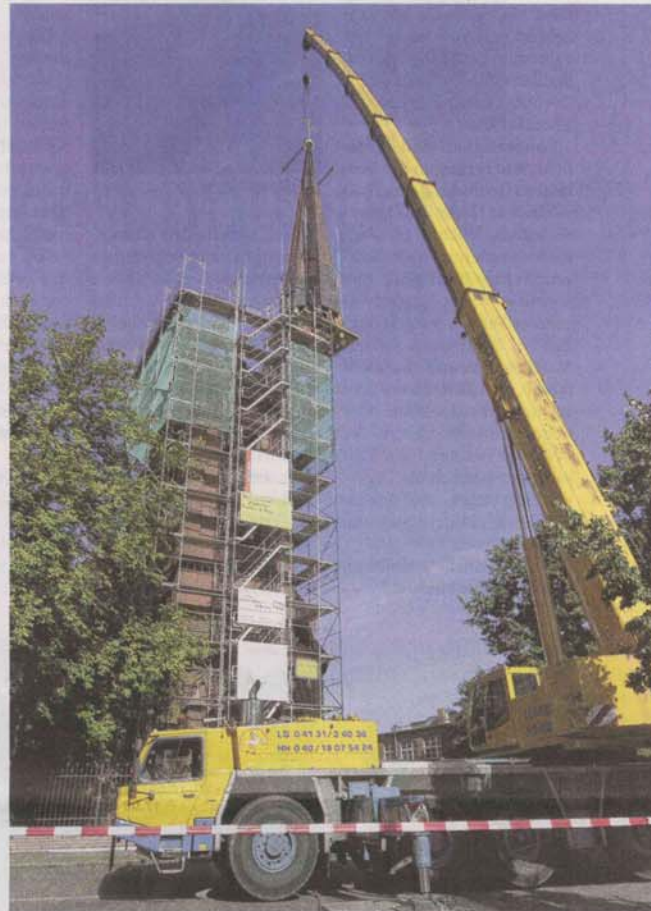
Präzise hebt der Kranführer die 14 Tonnen schwere Turmspitze an ihren Platz. FOTO: LARS REINHOLD
