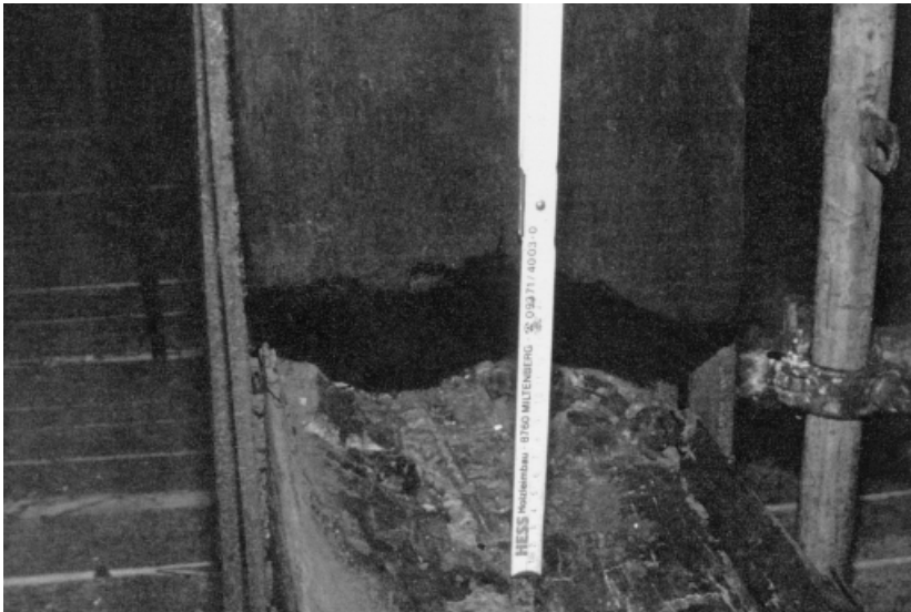
Bild 7. Querschnittsreduzierung beim Spannbalken eines Hängewerks Fig. 7. Reduced cross section of suspension structure
