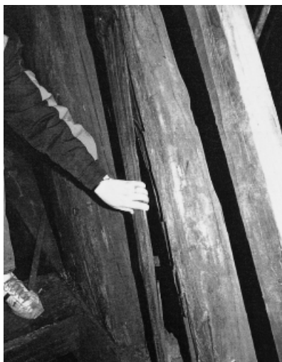
Bild 5. Typisches Schadensbild – Querschnittsauflösung an einem Dachsparren
