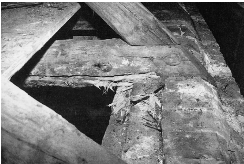
Bild 8. Durch Pilzbefall geschädigter Balkenkopf der Dachgeschoßdecke Fig. 8. Floor beam damaged by fungus attack
