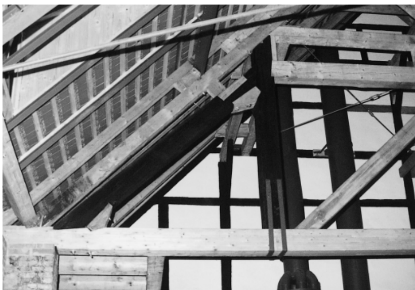
Bild 10. Instandgesetztes Hängewerk mit Neu- und Altholz (in Achse X5, Instandsetzung am Richtplatz nach Demontage mit Neuholz für Spannbalken, Streben, Spannriegel und Verstärkung der Versätze) Fig. 10. Suspension structure after repair (repair on the carpentry place)
