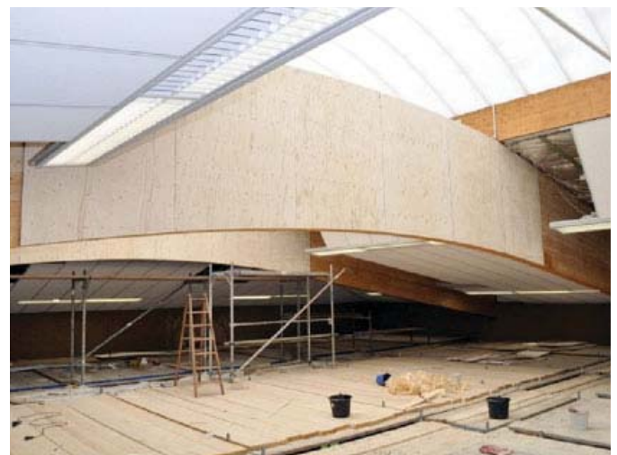
Bild 3. Aufkleben von Verstärkungsplatten im querzugbeanspruchten Bereich eines Hallenbinders aus Brettschichtholz; links: die Schrauben werden zur Einhaltung gleicher Abstände mittels Schablone eingeschraubt; rechts: fertige Verstärkung Fig. 3. Adhesive bonding of wood-based panels in areas of transverse/lateral tensile load of a hall girder made of glued-laminated timber; left: using a template to screw with similar distance between the screws; right: finished strengthening
