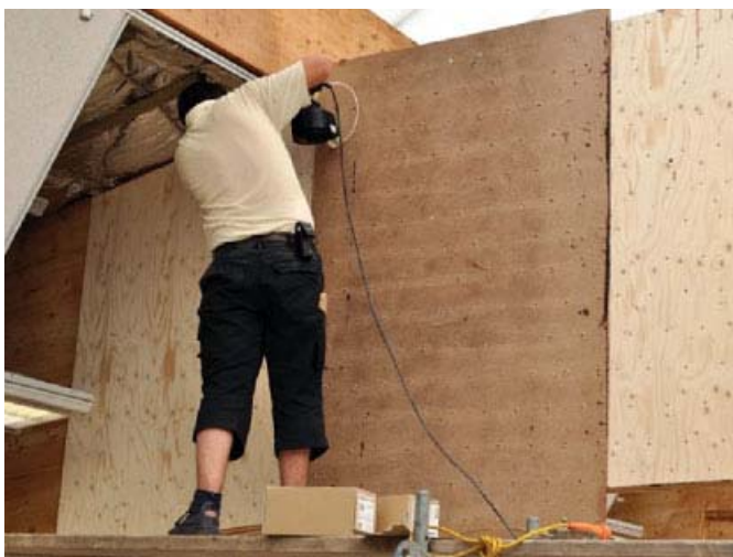
Bild 3. Aufkleben von Verstärkungsplatten im querzugbeanspruchten Bereich eines Hallenbinders aus Brettschichtholz; links: die Schrauben werden zur Einhaltung gleicher Abstände mittels Schablone eingeschraubt; rechts: fertige Verstärkung Fig. 3. Adhesive bonding of wood-based panels in areas of transverse/lateral tensile load of a hall girder made of glued-laminated timber; left: using a template to screw with similar distance between the screws; right: finished strengthening
