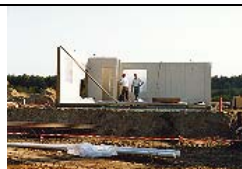
Erste Eckverbindung und Innenwandanschlüsse
