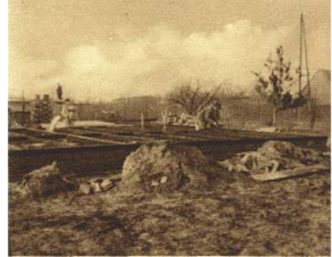
10.00 Uhr: Die Schwellen sind gelegt.
