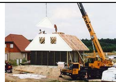
Die Dachbinder sind teilmontiert.
