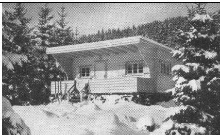
Skihütte 1) Entwurf und Ausführung: Christoph & Unmack Rohbau fertig nach zwei Arbeitstagen
