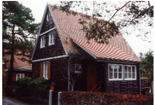
Einfamilienhäuser der Siedlung in Dresden-Hellerau, Am Sonnenhang, 1933 in Jalousie- und Holztafelbauweise errichtet
