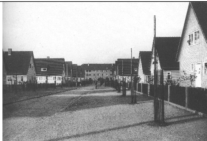
Einzel- und Reihenhäuser, Architekt Eugen Schwemmlé 2)
