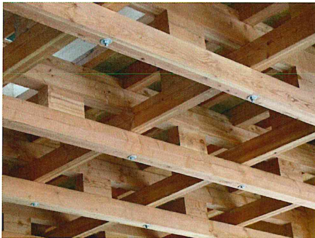
Bild 2: Trägerrostkonstruktion 9x9/12x12 m aus Duobalken nach Z.9.1-440
